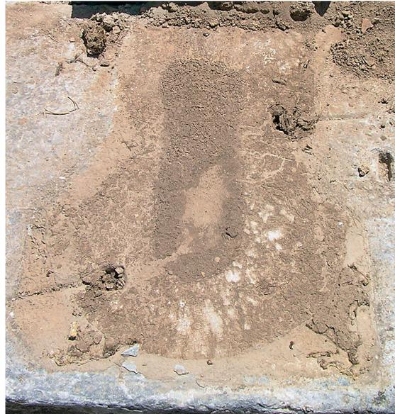
Abb. 3 Aphrodisias, ›South Building‹ des Sebasteions: Stylobat unmittelbar nach Abheben der Säulenbasis im Rahmen von Konservierungsmaßnahmen. Blei befindet sich in den Dübellöchern, nicht aber im Gusskanal. Im gesamten Bereich haben sich Humus und Verunreinigungen angesammelt.
