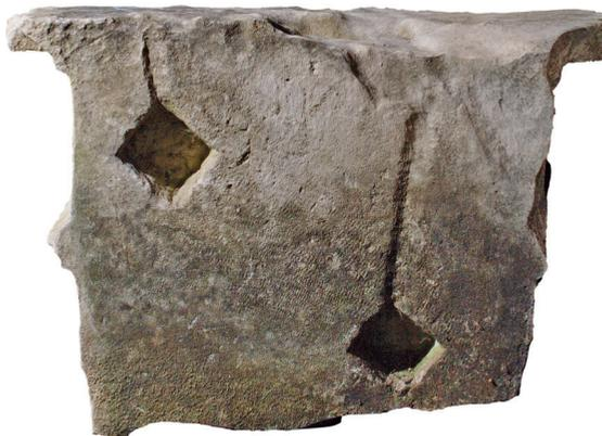
Abb. 2 Limyra, Bogentor beim Ptolemaion: Keilstein mit Dübellöchern und Gusskanälen
