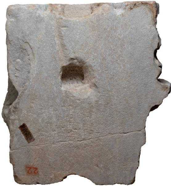
Abb. 1 Ephesos, sog. Hadrianstempel an der Kuretenstraße: Keilstein vom Bogen mit Dübelloch und Gusskanal zum nachträglichen Bleiverguss
