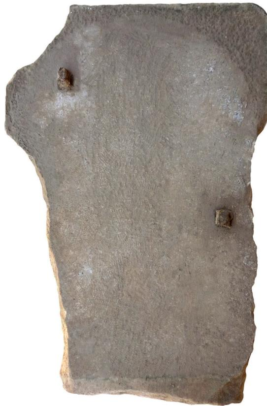
Abb. 4 Aphrodisias, ›South Building‹ des Sebasteions: Unterseite der zugehörigen Säulenbasis mit originalen Eisendübeln in situ
