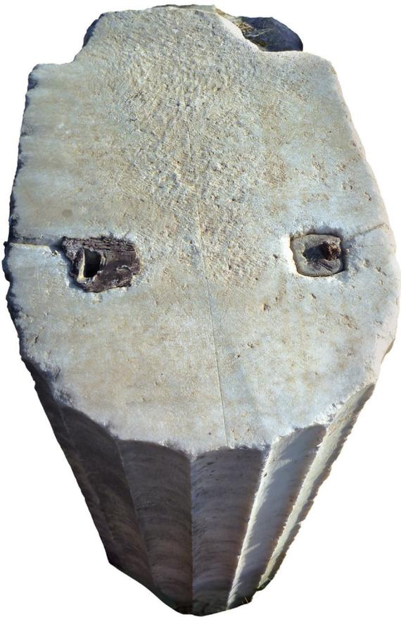
Abb. 10 Aphrodisias, »North Building« des Sebasteions: Halbsäulenpfeiler mit Bleiverguss in situ. Im linken Dübelloch wurde der Eisendübel nachträglich, wohl rezent entfernt.
